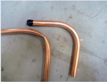
obr. 1 Nikdy nesmí dojít k zalomení potrubí.
